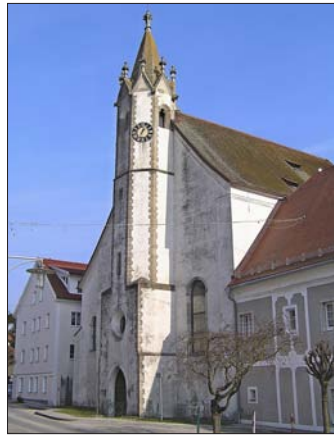
Die Spitalkirche in Eferding wird derzeit renoviert.
