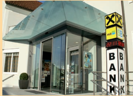
Die neu gestaltete Raiffeisenbank St. Marienkirchen.
