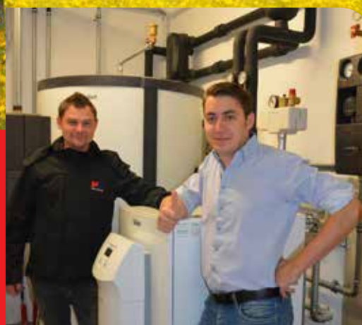
Andreas Achleitner mit Michael Brummeier bei der Wasser/Wasser-Wärmepumpe mit hygienischer Warmwasseraufbereitung.
